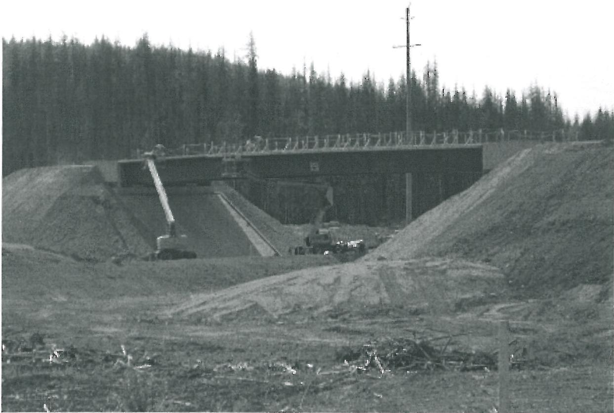
Les remblais, tels que ceux représentés sur la photo au-dessus, sont souvent utilisés pour soutenir les viaducs routiers. Ils doivent être relativement forts et incompressible pour la stabilité et pour éviter les tassements différentiels qui pourraient endommager le viaduc ou la chaussée.
